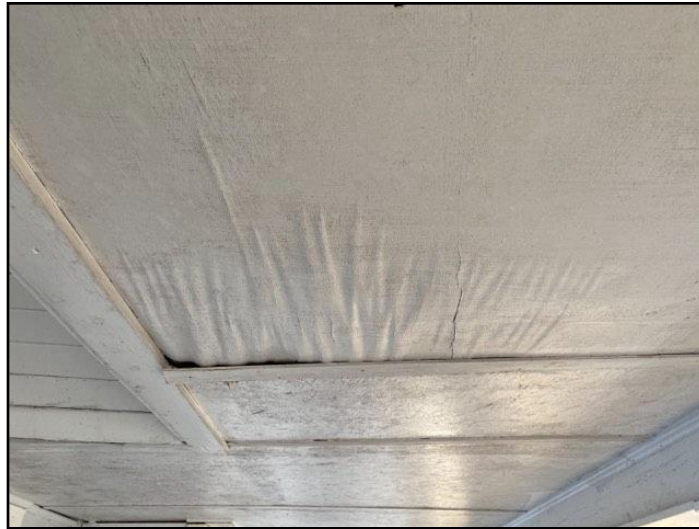
9. Rotten Soffit
